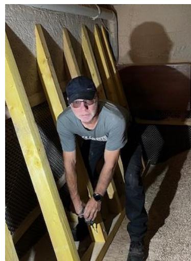
Intervention dans la chaufferie
