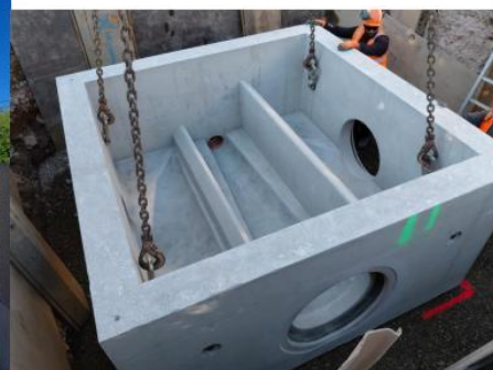
Pose du déversoir d'orage
