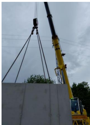
Pose de la chambre de régulation de débit
