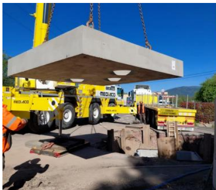
Pose du déversoir d'orage
