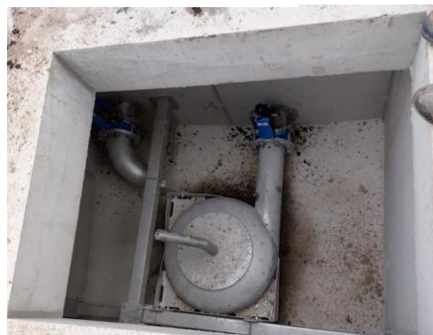
Pose de la chambre de régulation de débit
