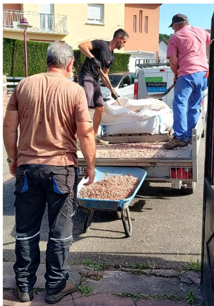
Remise en état des allées du cimetière
