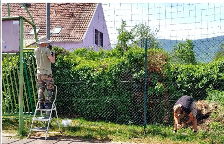
Réparations au city-stade
