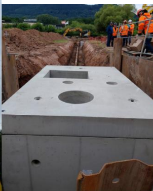
Pose de la chambre de régulation de débit
